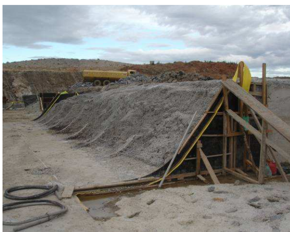
FOTO 121 - SANGRADOURO – VISTA PARCIAL DO CONCRETO EXECUTADO NO PERFIL CREAGER - MÓDULO 6
