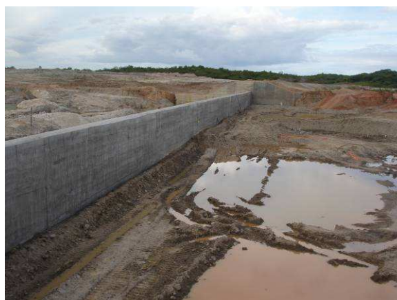
FOTO 156 - SANGRADOIRO – FACE MONTANTE DO PERFIL CREAGER.
