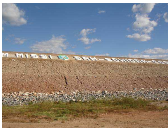
FOTO 54 – LETREIRO NO PARAMENTO DE JUSANTE.
