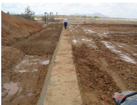
FOTO 97 – TOMADA D'ÁGUA – VISTA PARCIAL DA FACE SUPERIOR DA GALERIA E TRECHO COMPACTADO NO ESPALDAR DE MONTANTE.
