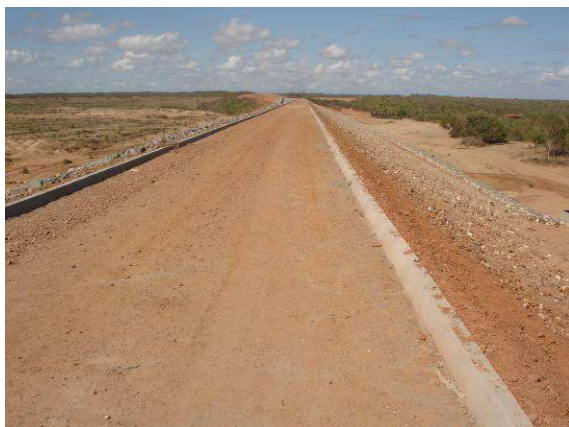
FOTO 45 – VISTA PARCIAL DO COROAMENTO.
