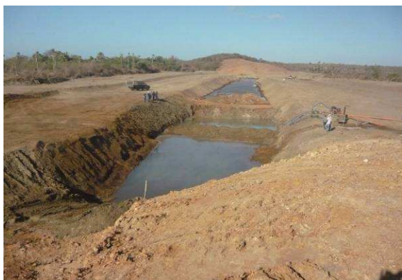
FOTO 15 – ESCAVAÇÃO DA FUNDAÇÃO PRÓXIMA A OMBREIRA DIREITA DO MACIÇO PRINCIPAL.
