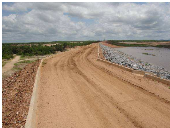
FOTO 46 – COROAMENTO A PARTIR DA OMBREIRA ESQUERDA
