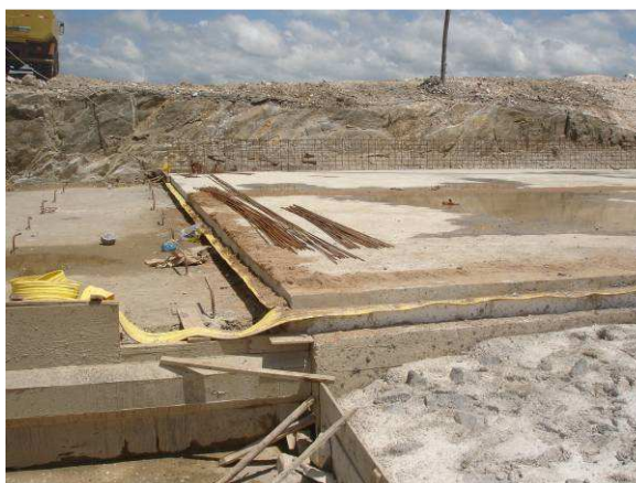
FOTO 119 - SANGRADOURO – DETALHE DA JUNTA FUNGENBAND ENTRE AS LAJES DOS MÓDULOS 3 E 4
