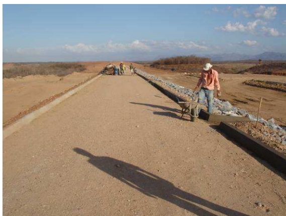
FOTO 63 - BARRAGEM AUXILIAR – 1 (BA – 01) EXECUÇÃO DE MEIO FIO
