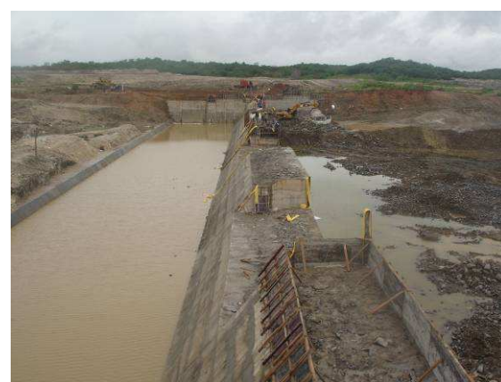
FOTO 150 - SANGRA DOURO - BACIA DE DISSIPAÇÃO E MÓDULOS 1 AO 5 DO PERFIL CREAGER. AO FUNDO MURO DIREITO EM EXECUÇÃO.
