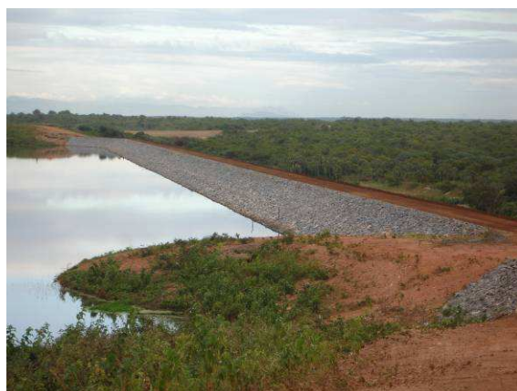
FOTO 52 – VISTA PARCIAL DO LAGO E PROTEÇÃO DO TALUDE DE MONTANTE A PARTIR DA OMBREIRA DIREITA
