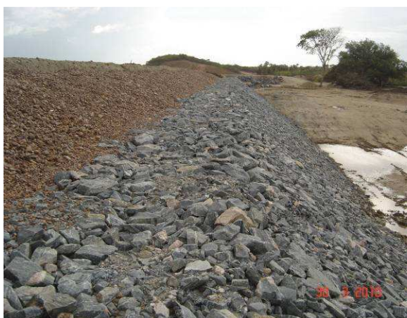
FOTO 29 – ROCK-FIL E PROTEÇÃO DO TALUDE JUSANTE
