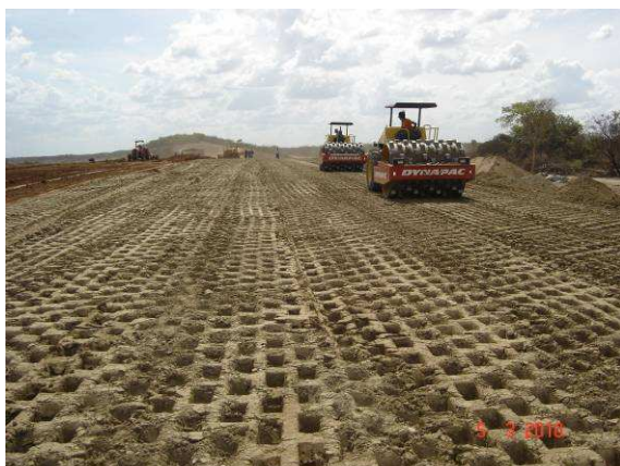
FOTO 33 – VISTA GERAL DA COMPACTAÇÃO COM ROLO
