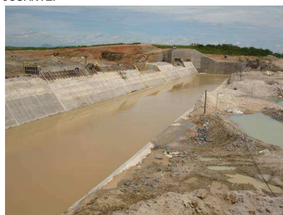
FOTO 149 - SANGRA DOURO - BACIA DE DISSIPAÇÃO (COM ÁGUA). EM CONSTRUÇÃO OS MÓDULOS 1 AO 7 DO PERFIL CREAGER. AO FUNDO MURO ESQUERDO EM CONCLUSÃO
