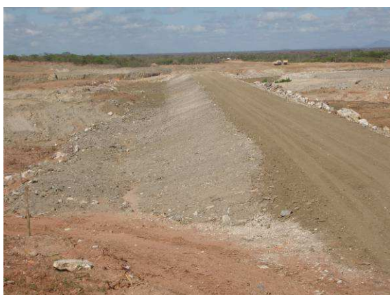
FOTO 69 - BARRAGEM AUXILIAR - 3 (BA - 3) TALUDE DE MONTANTE
