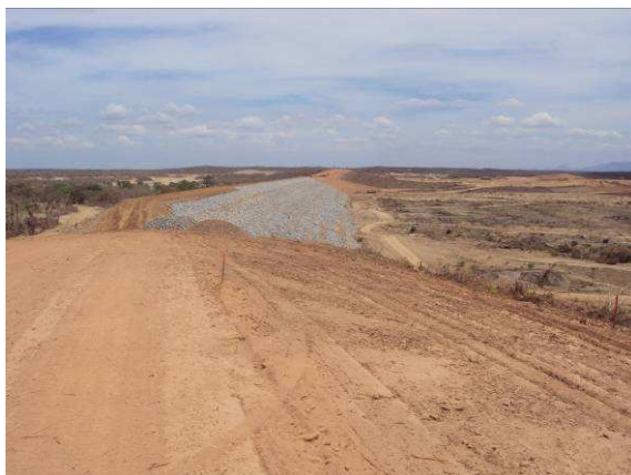
FOTO 43 – VISTA DO COROAMENTO E PROTEÇÃO TALUDE MONTANTE A PARTIR DA OMBREIRA ESQUERDA.
