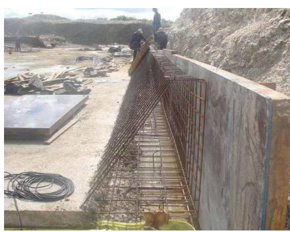
FOTO 122 - SANGRADOURO – FORMA E FERRAGEM DO MURO FRONTAL.
