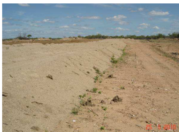
FOTO 58 – BARRAGEM AUXILIAR - 1 (BA - 01) DRENO HORIZONTAL - TAPETE DE AREIA.
