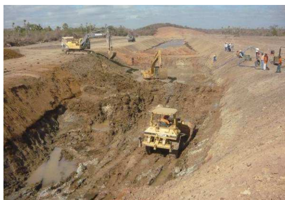
FOTO 16 – ESCAVAÇÃO DA FUNDAÇÃO NA SEÇÃO 51 DO MACIÇO PRINCIPAL
