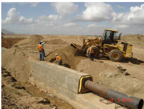
FOTO 95 – TOMADA D'ÁGUA – COLOCAÇÃO DE AREIA NO ESPALDAR DE JUSANTE.
