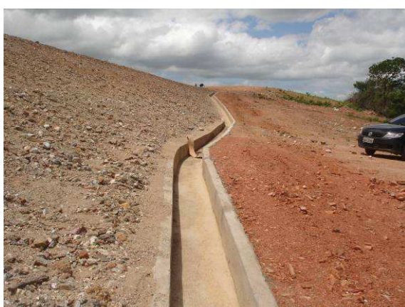
FOTO 47 – CALHA DE DRENAGEM NA OMBREIRA ESQUERDA.
