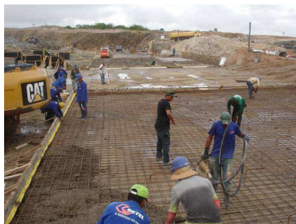
FOTO 120 - SANGRADOURO – CONCRETAGEM DA LAJE DO MÓDULO 8 NA BACIA DE DISSIPAÇÃO
