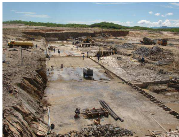
FOTO 118 - SANGRADOURO – VISTA DA OBRA NO FINAL DO MÊS DE FEVEREIRO/11
