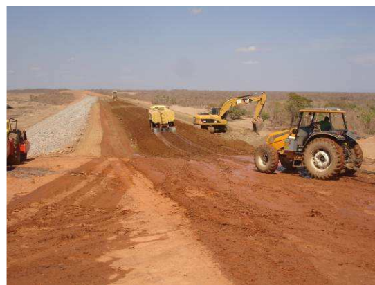
FOTO 40 - CORREÇÃO DA UMIDADE DA CAMADA DE SOLO À MONTANTE.
