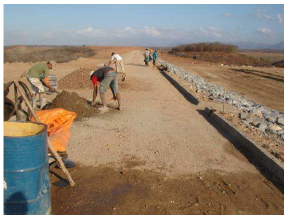
FOTO 64 - BARRAGEM AUXILIAR – 1 (BA – 01) EXECUÇÃO DE MEIO FIO
