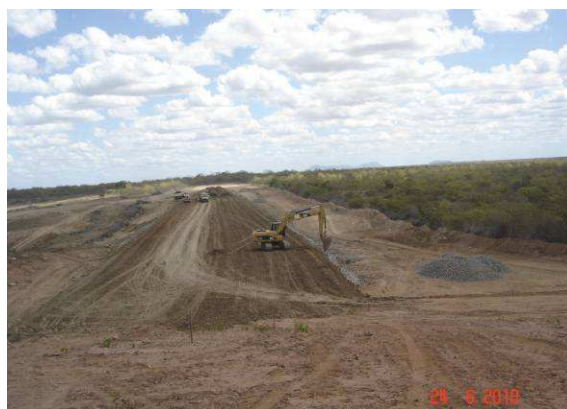
FOTO 60 – BARRAGEM AUXILIAR - 1 (BA - 01) VISTA GERAL DA EXECUÇÃO DO MACIÇO.
