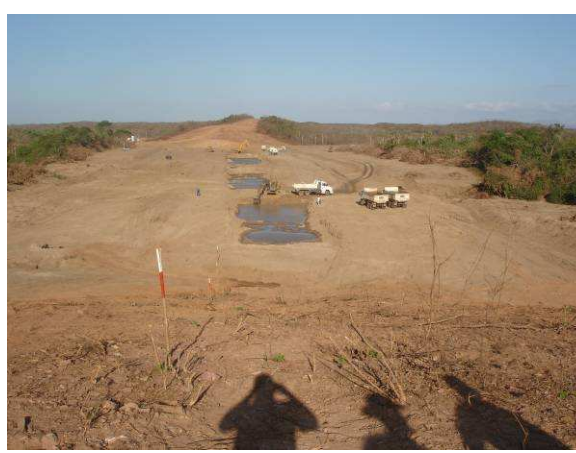
FOTO 12 – ÁREA DESMATADA E EXPURGADA NO LOCAL DO MACIÇO PRINCIPAL.
