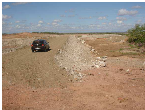
FOTO 68 - BARRAGEM AUXILIAR - 3 (BA - 3) - VISTA GERAL DO MACIÇO E TALUDE DE JUSANTE
