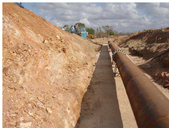
FOTO 92 – TOMADA D'ÁGUA – TUBULAÇÃO PRÉ-ASSENTADA.
