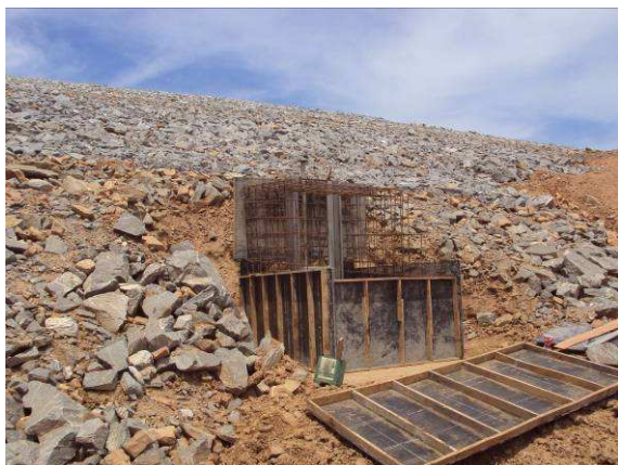
FOTO 107 – TOMADA D'ÁGUA – CAIXA DE MONTANTE FERRAGEM E FORMA.
