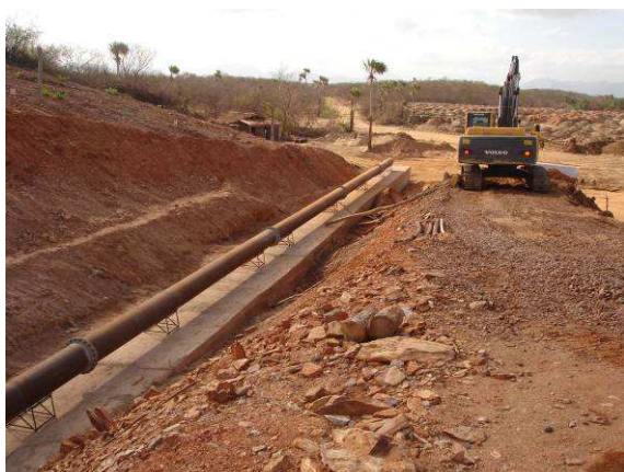
FOTO 91 – TOMADA D'ÁGUA – TUBULAÇÃO PRÉ-ASSENTADA.
