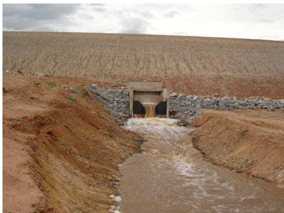
FOTO 105 – TOMADA D'ÁGUA – VISTA DA PASSAGEM DE ÁGUA ATRAVÉS DO VERTEDOURO TRIANGULAR
