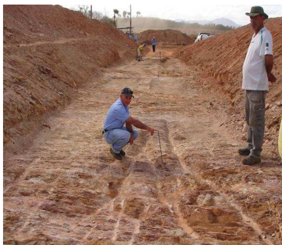
FOTO 87 – LOCAÇÃO DO EIXO DA TOMADA D'ÁGUA.
