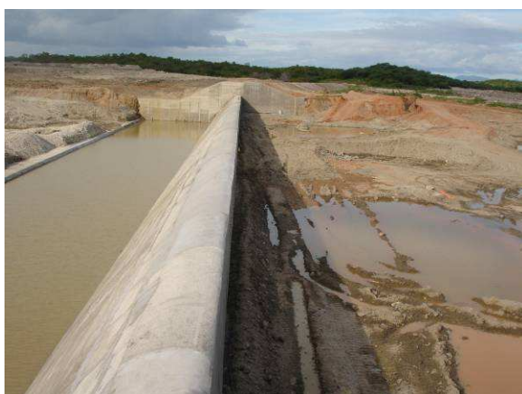
FOTO 155 - SANGRADOIRO – CRISTA DO PERFIL CREAGER. MURO DIREITO AO FUNDO.
