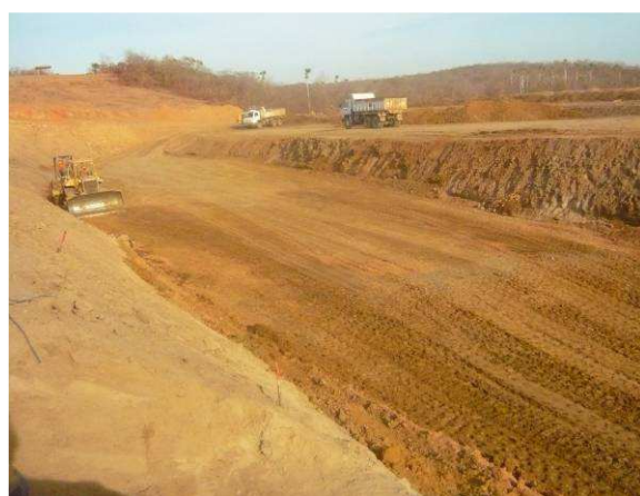
FOTO 18 – ATERRO NA FUNDAÇÃO PRÓXIMO A SEÇÃO 52 NA OMBREIRA DIREITA.
