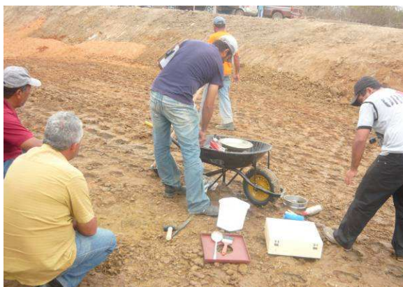
FOTO 21 – REALIZAÇÃO DOS PRIMEIROS ENSAIOS DE DENSIDADE “IN SITU”.
