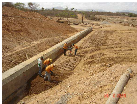
FOTO 96 – TOMADA D'ÁGUA – COMPACTAÇÃO MANUAL COM SAPO NO LADO DE MONTANTE.
