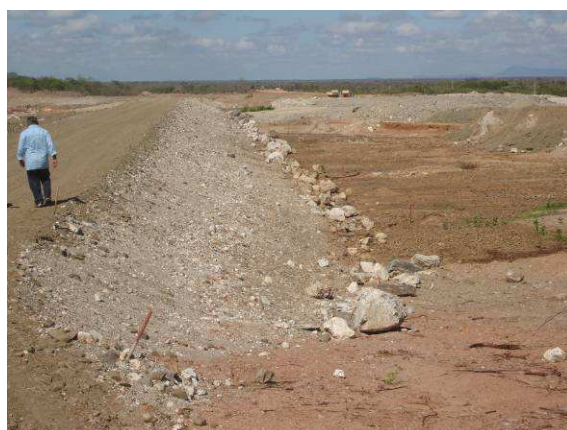
FOTO 70 - BARRAGEM AUXILIAR - 3 (BA - 3) TALUDE DE JUSANTE
