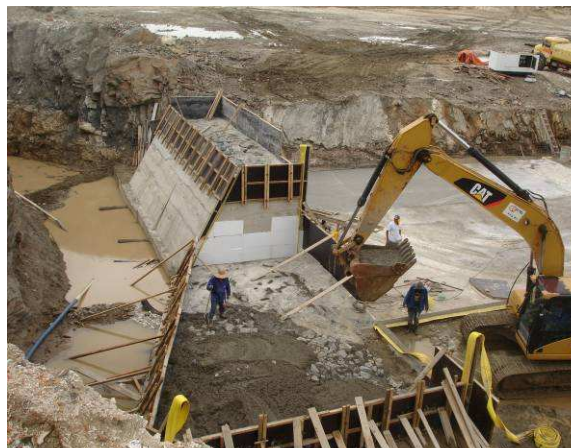
FOTO 136 - SANGRADOURO – EM CONSTRUÇÃO OS MUROS 5, 4 E 3 DO LADO ESQUERDO.
