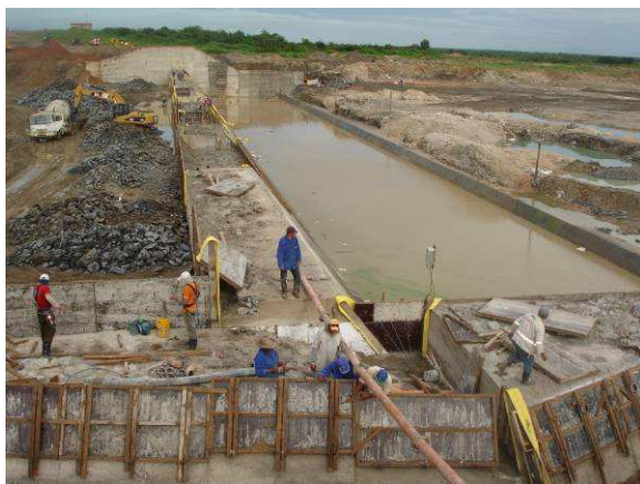
FOTO 145 - SANGRA DOURO - EM CONSTRUÇÃO OS MUROS 3 E 4 DO LADO ESQUERDO.
