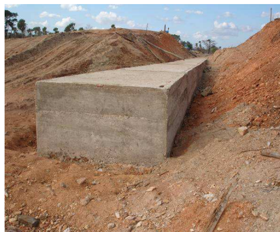
FOTO 90 – EXTREMIDADE DE MONTANTE DA BASE DE CONCRETO DE REGULARIZAÇÃO DA TOMADA D'ÁGUA.
