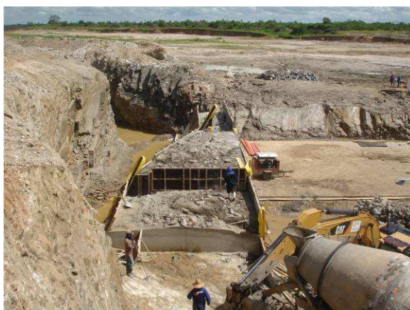
FOTO 137 - SANGRADOURO – VISTA DOS MUROS DO LADO ESQUERDO
