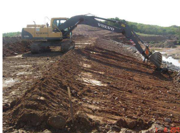
FOTO 36 –REGULARIZAÇÃO DO TALUDE DE MONTANTE.
