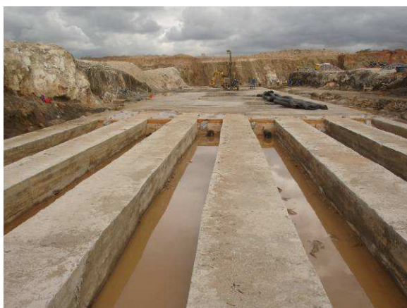
FOTO 113 - MURETAS DE REFORÇO DA ROCHA E VALAS DE DRENAGEM.
