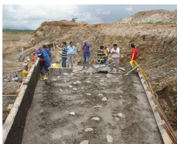
FOTO 144 - SANGRA DOURO - TÉCNICOS DO MINISTÉRIO DA INTEGRAÇÃO NA CONCRETAGEM DO MURO 5 DO LADO ESQUERDO
