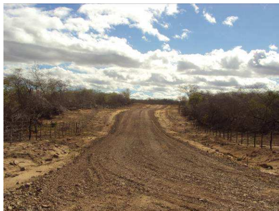
FOTO 8 – ESTRADA DE CONTORNO PELA MARGEM ESQUERDA EM EXECUÇÃO.
