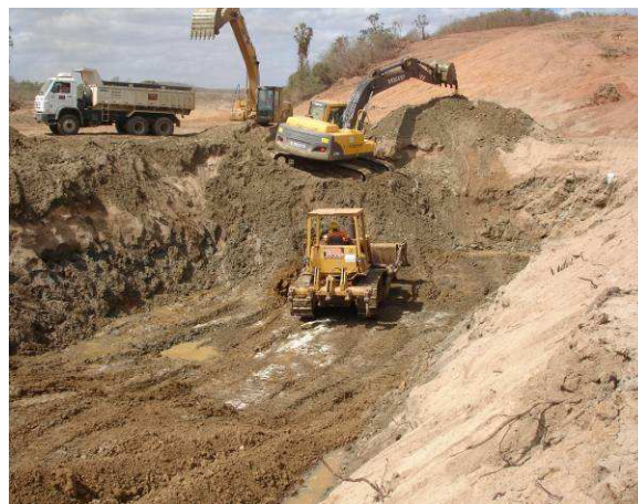
FOTO 80 – ESCAVAÇÃO DA FUNDAÇÃO FUNDAÇÃO NA OMBREIRA ESQUERDA
