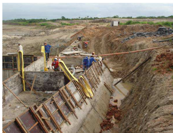
FOTO 148 - SANGRA DOURO - EXECUÇÃO DOS MUROS 2 E 3 DO LADO ESQUERDO.
