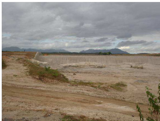
FOTO 157 - SANGRADOURO – VISTA FRONTAL DO PERFIL CREAGER E PARTE DO MURO DIREITO.
