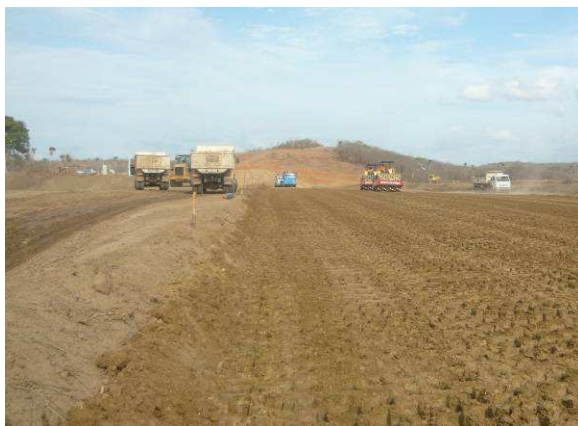
FOTO 25 – EXECUÇÃO DE ATERRO.
