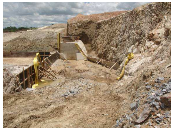
FOTO 140 - SANGRA DOURO - VISTA DO MURO 5 E BASE CONCRETADA DO 4 NO LADO DIREITO.
