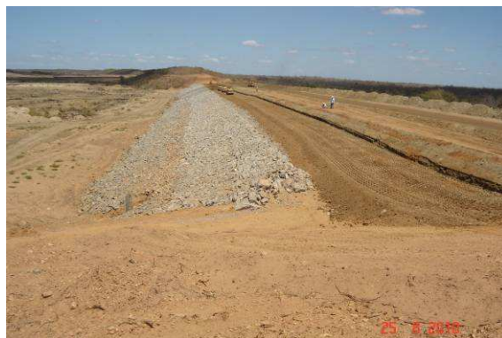
FOTO 42 – VISTA GERAL DA PROTEÇÃO NO TALUDE DE MONTANTE A PARTIR DA OMBREIRA DIREITA.
