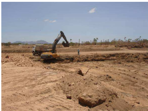
FOTO 13 – ESCAVAÇÃO DA FUNDAÇÃO E CAMADA SUPERFICIAL
