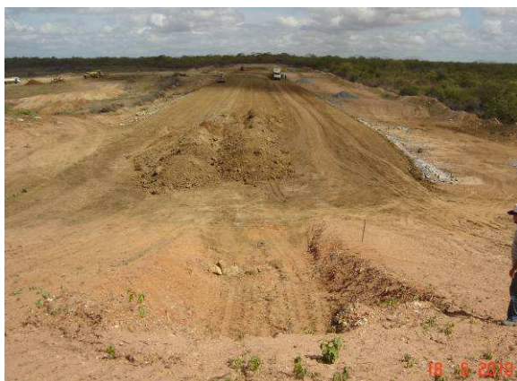
FOTO 57 – BARRAGEM AUXILIAR - 1 (BA - 01) EXECUÇÃO DO MACIÇO
