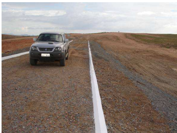
FOTO 73 - BARRAGEM AUXILIAR – 2 (BA – 2) COROAMENTO, MEIO FIO E TALUDE DE JUSANTE
