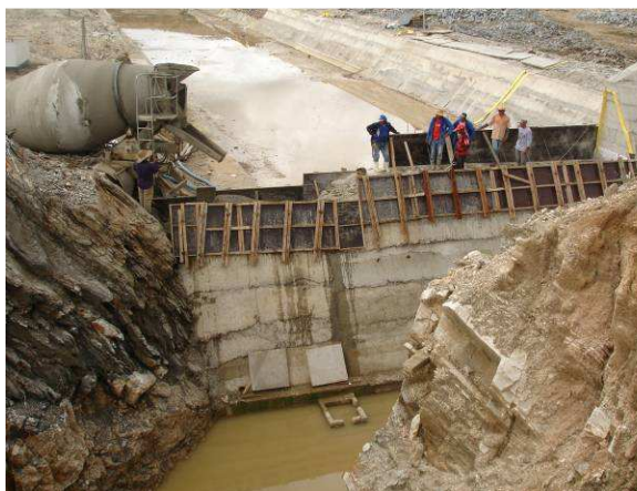
FOTO 147 - SANGRA DOURO - VISTA DO MURO ESQUERDO 5 NO ENCONTRO COM A ROCHA A JUSANTE.
