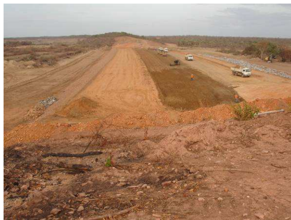
FOTO 26 – VISTA GERAL DA EXECUÇÃO DO MACIÇO PRINCIPAL ENTRE AS ESTACAS 40 E 52.
