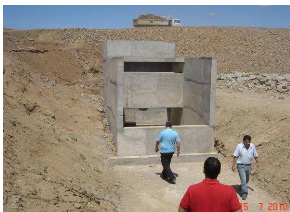
FOTO 103 – TOMADA D'ÁGUA – ESTRUTURA DE CONCRETO CONCLUÍDA DA CAIXA DE JUSANTE
