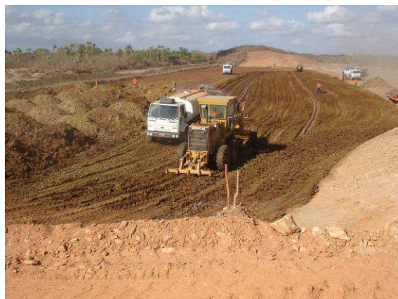
FOTO 24 – ESCARIFICAÇÃO E UMEDECIMENTO DE MATERIAL NO ESPALDAR DE MONTANTE.
