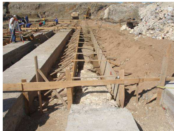
FOTO 112 - EXECUÇÃO DAS MURETAS DE CONCRETO DE REFORÇO DA ROCHA.
