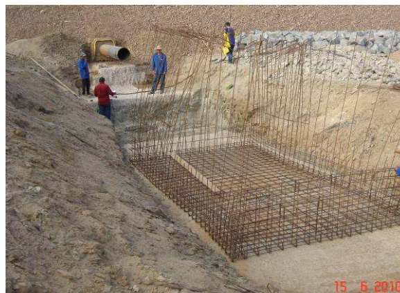
FOTO 100 – TOMADA D'ÁGUA - FERRAGEM DA CAIXA DE JUSANTE.
