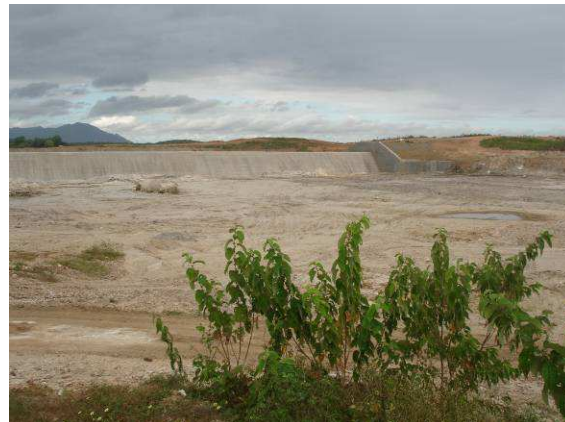
FOTO 158 - SANGRADOURO – VISTA FRONTAL DO PERFIL CREAGER E PARTE DO MURO ESQUERDO.
