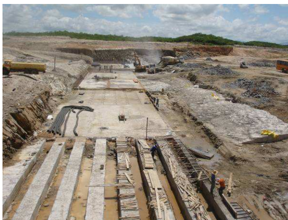
FOTO 117 - SANGRADOURO – VISTA GERAL DA OBRA NO INÍCIO DE FEVEREIRO/11.
