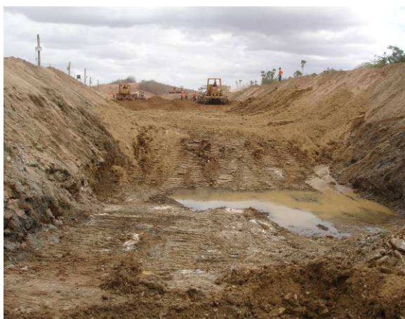
FOTO 83 – ENCHIMENTO DA FUNDAÇÃO
