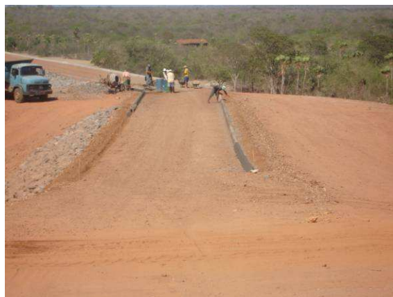
FOTO 44 – EXECUÇÃO DO MEIO FIO NO MACIÇO PRINCIPAL.
