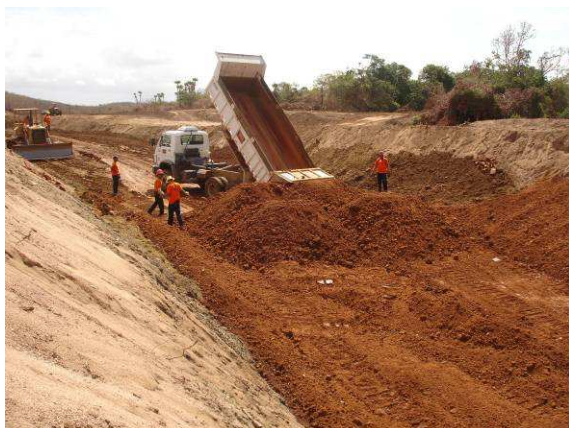
FOTO 19 – COLOCAÇÃO DE MATERIAL NO CUT=OFF.
