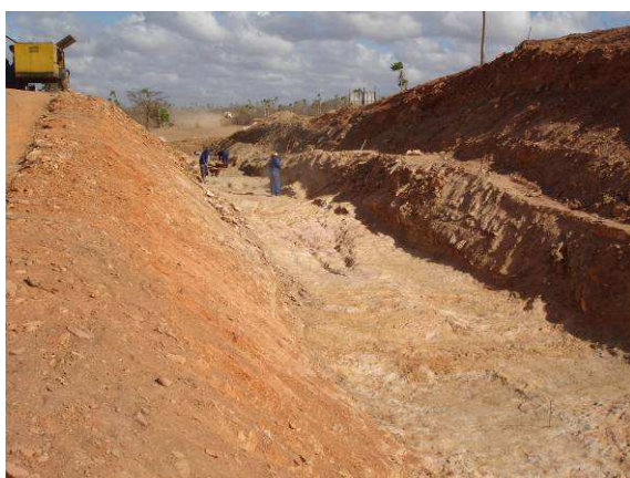
FOTO 85 – ESCAVAÇÃO DA FUNDAÇÃO DA TOMADA D'ÁGUA
