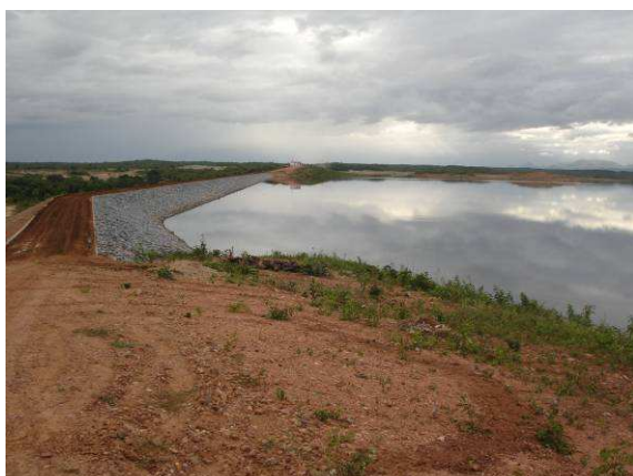
FOTO 51 – VISTA PARCIAL DO LAGO E PROTEÇÃO DO TALUDE DE MONTANTE A PARTIR DA OMBREIRA ESQUERDA
