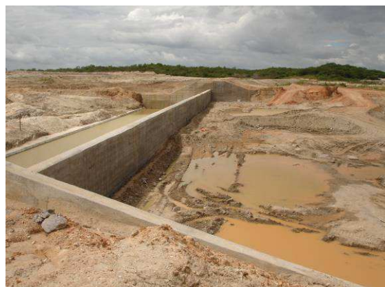
FOTO 159 - SANGRADOURO – FACE DE MONTANTE DO PERFIL CREAGER.
