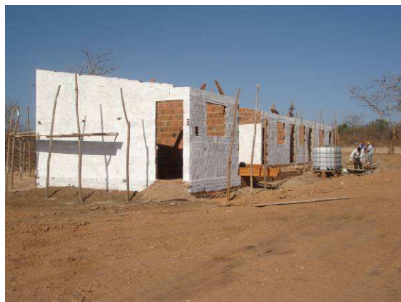
FOTO 2 – CANTEIRO EM CONSTRUÇÃO
