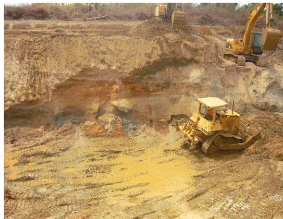
FOTO 76 - MACIÇO PRINCIPAL - ESCAVAÇÃO DA FUNDAÇÃO ENTRE A EST. 50 E 52
