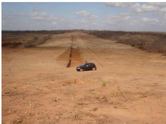
FOTO 55 – BARRAGEM AUXILIAR - 1 (BA - 01) ESCAVAÇÃO DA FUNDAÇÃO
