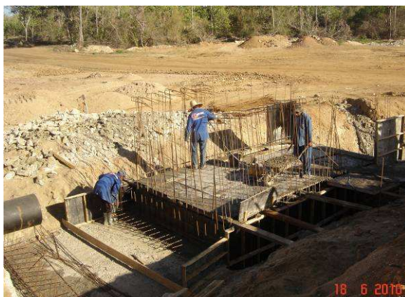
FOTO 101 – TOMADA D'ÁGUA – CONCRETAGEM DA CAIXA DE JUSANTE.
