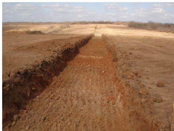
FOTO 56 – BARRAGEM AUXILIAR BA - 1 (BA - 01) ESCAVAÇÃO DA FUNDAÇÃO
