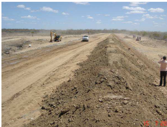
FOTO 61 - BARRAGEM AUXILIAR – 1 (BA – 01) MATERIAL EMPILHADO PARA EXECUÇÃO DO MACIÇO.
