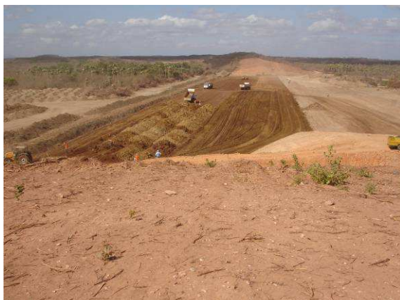
FOTO 23 – VISTA GERAL DA EXECUÇÃO DO ESPALDAR DE MONTANTE
