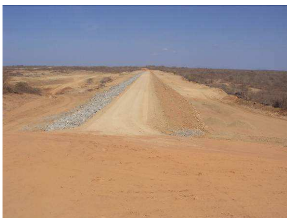
FOTO 65 - BARRAGEM AUXILIAR – 1 (BA – 01) - VISTA GERAL DO MACIÇO CONCLUÍDO.
