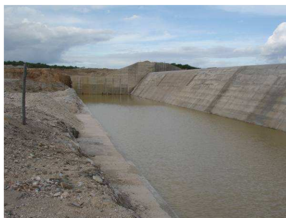
FOTO 154 - SANGRADOIRO – PARTE DA BACIA DE DISSIPAÇÃO, PERFIL CREAGER A JUSANTE E MURO DIREITO AO FUNDO.
