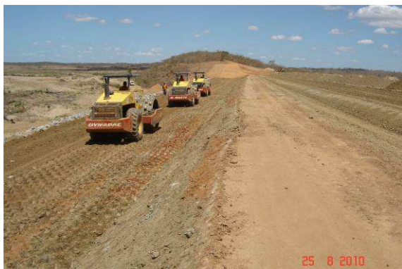
FOTO 41- COMPACTAÇÃO DE SOLO NO ESPALDAR DE MONTANTE.
