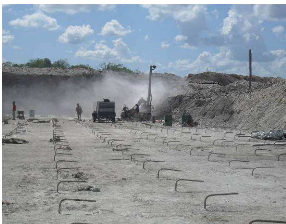
FOTO 115 - SANGRADOIRO - TIRANTES CONCRETADOS. AO FUNDO EXECUÇÃO DE FUROS PARA COLOCAÇÃO
