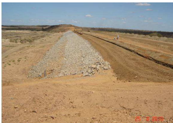
FOTO 39– VISTA GERAL DO RIP-RAP
