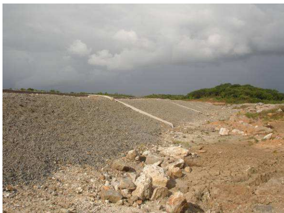
FOTO 71 - BARRAGEM AUXILIAR - 3 (BA - 3) PROTEÇÃO DO TALUDE DE MONTANTE
