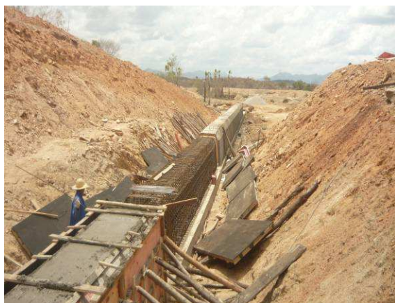
FOTO 93 – TOMADA D'ÁGUA – VISTA PARCIAL DE TRECHO COM FORMA E ESCORA, FERRAGEM E CONCRETADO.
