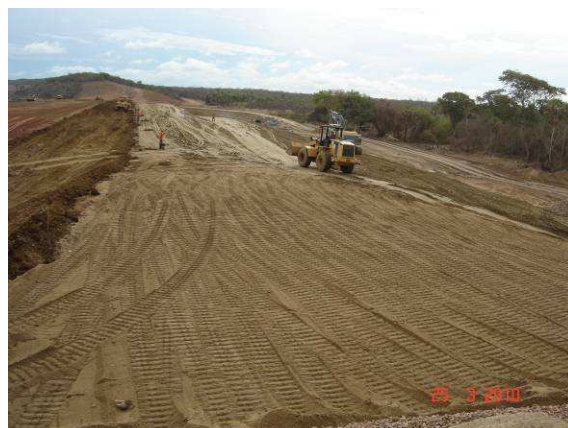
FOTO 34 – EXECUÇÃO DO TAPETE DRENANTE
