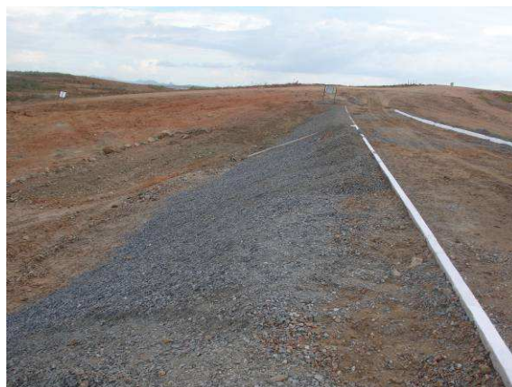
FOTO 74 - BARRAGEM AUXILIAR – 2 (BA – 2) TALUDE DE MONTANTE, MEIO FIO E PARTE DO COROAMENTO
