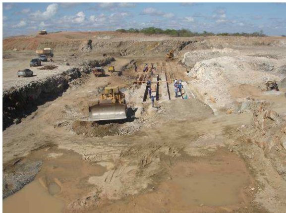
FOTO 111 - ESCAVAÇÃO E EXECUÇÃO DAS MURETAS DE DRENAGEM.
