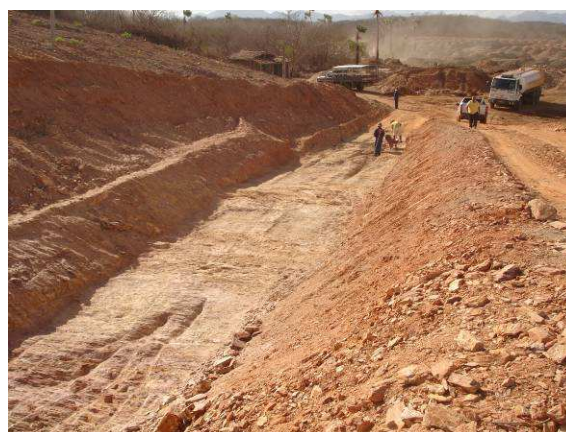
FOTO 86 – TOPO ROCHOSO NO LOCAL ONDE SERÁ IMPLANTADA TOMADA D'ÁGUA
