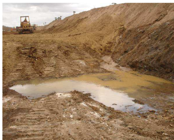
FOTO 84 – ENCHIMENTO DA FUNDAÇÃO
