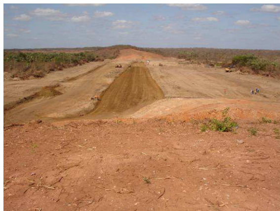
FOTO 20 – VISTA GERAL DO ENCHIMENTO DA FUNDAÇÃO DO MACIÇO PRINCIPAL.
