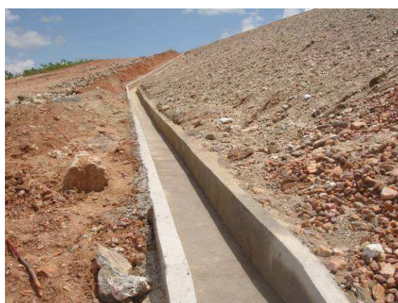
FOTO 48 – CALHA DE DRENAGEM NA OMBREIRA DIREITA.
