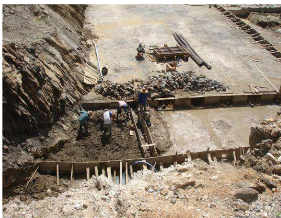
FOTO 135 - SANGRADOURO – VISTA DA EXECUÇÃO DO MURO ESQUERDO 5.
