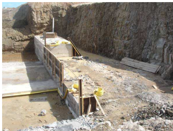
FOTO 134 - SANGRADOURO – EXECUÇÃO PARCIAL DOS MUROS DIRETOS 3,4 E 5.
