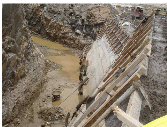
FOTO 138 - SANGRADOURO – FACE RAMPADA DOS MUROS 4 E 5 DO LADO ESQUERDO.
