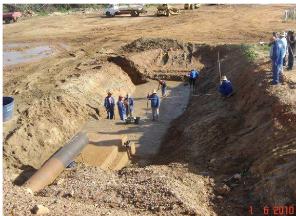
FOTO 99 – TOMADA D'ÁGUA - REGULARIZAÇÃO DO TERRENO PARA EXECUÇÃO DA CAIXA DE JUSANTE.
