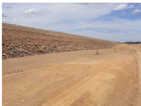
FOTO 66 - BARRAGEM AUXILIAR – 1 (BA – 01) TALUDE DE JUSANTE
