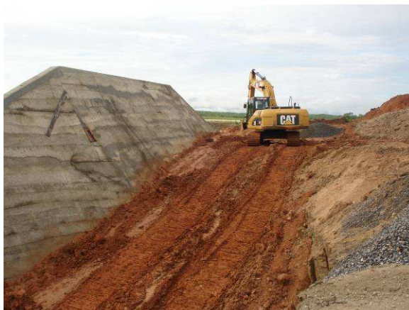
FOTO 151 - SANGRADOIRO – EXECUÇÃO DO ATERRO DE CONCORDÂNCIA NO MURO DO LADO ESQUERDO.
