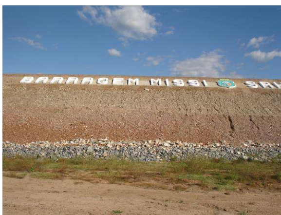
FOTO 53 – LETREIRO NO PARAMENTO DE JUSANTE
