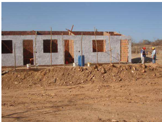
FOTO 1 – EXECUÇÃO DO CANTEIRO
