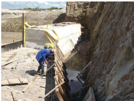
FOTO 139 - SANGRA DOURO - COLOCAÇÃO DE FORMA NO MURO 4 DO LADO DIREITO
