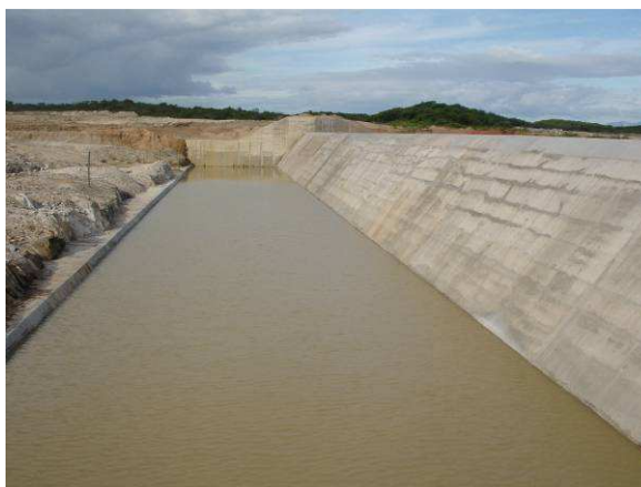
FOTO 153 - SANGRADOIRO – BACIA DE DISSIPAÇÃO, LADO JUSANTE DO PERFIL CREAGER E AO FUNDO MURO LATERAL DIREITO
