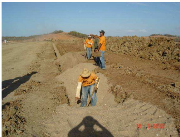
FOTO 31- EXECUÇÃO DO FILTRO VERTICAL
