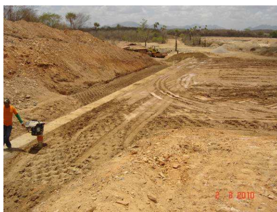
FOTO 98 – TOMADA D'ÁGUA – VISTA GERAL DO PARAMENTO DE MONTANTE COMPACTADO ATÉ O NÍVEL DA GALERIA DE CONCRETO
