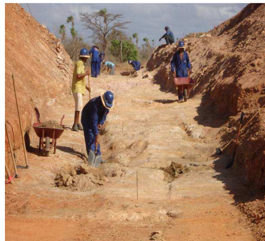
FOTO 88 – LIMPEZA DA ROCHA ONDE SERÁ ASSENTADA TOMADA D'ÁGUA.
