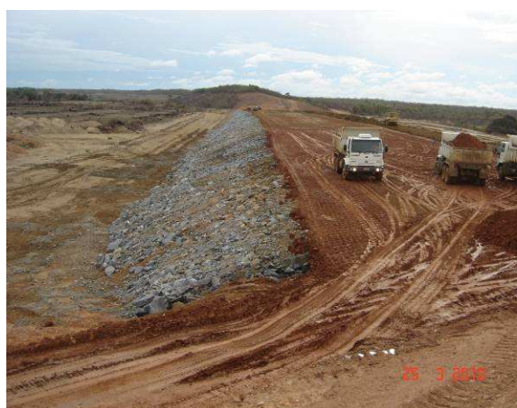
FOTO 30 – RIP-RAP - PROTEÇÃO DO TALUDE DE MONTANTE.
