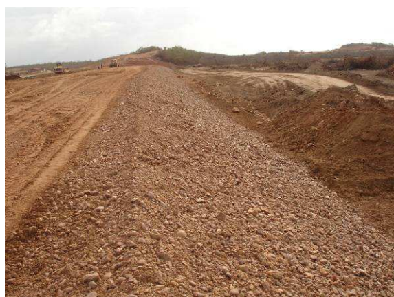
FOTO 28 – PROTEÇÃO DO TALUDE DE JUSANTE.
