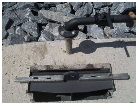
FOTO 110 – ALÇA DE IÇAMENTO DO STOP-LOG DA CAIXA DE MONTANTE DA TOMADA D'ÁGUA.
