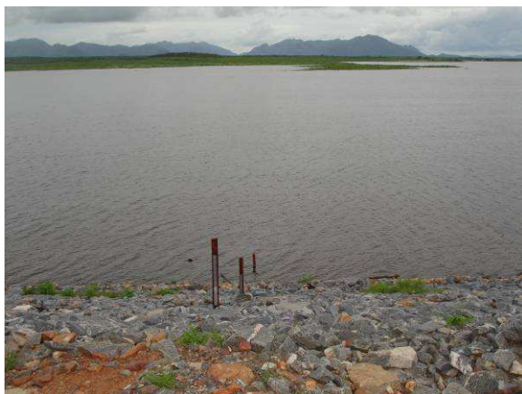
FOTO 49 – VISTA PARCIAL DO LAGO E DE RÉGUAS LINIMÉTRICAS
