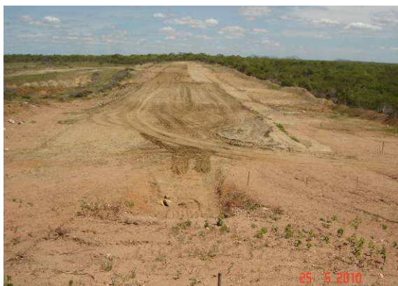
FOTO 59 – BARRAGEM AUXILIAR - 1 (BA - 01) - VISTA GERAL DA “PRAÇA”
