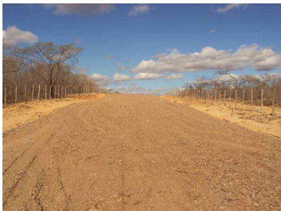
FOTO 7 – ESTRADA DE CONTORNO E CERCA COM ARAME FARPADO NA MARGEM DIREITA.
