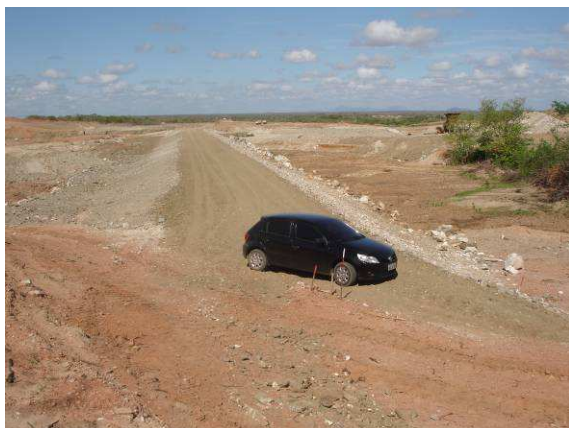
FOTO 67 - BARRAGEM AUXILIAR - 3 (BA - 3) - VISTA GERAL DO MACIÇO E TALUDE DE MONTANTE
