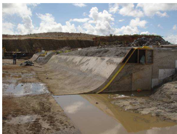
FOTO 142 - SANGRA DOURO - PARTE DO PERFIL CREAGER DO MÓDULO 6.
