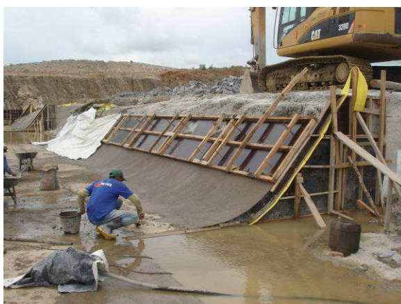
FOTO 141 - SANGRA DOURO - EXECUÇÃO DA CURVA INFERIOR DO PERFIL CREAGER.
