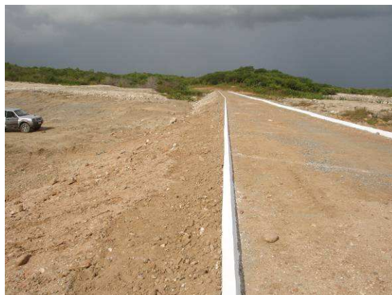
FOTO 72 - BARRAGEM AUXILIAR - 3 (BA - 3) COROAMENTO E MEIO FIO.
