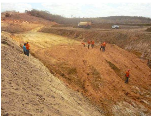
FOTO 17 – VISTA DAS PRIMEIRAS CAMADAS COMPACTADAS NO ENCHIMENTO DA FUNDAÇÃO.
