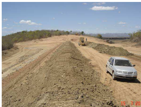
FOTO 62 - BARRAGEM AUXILIAR – 1 (BA – 01) EXECUÇÃO DO MACIÇO.
