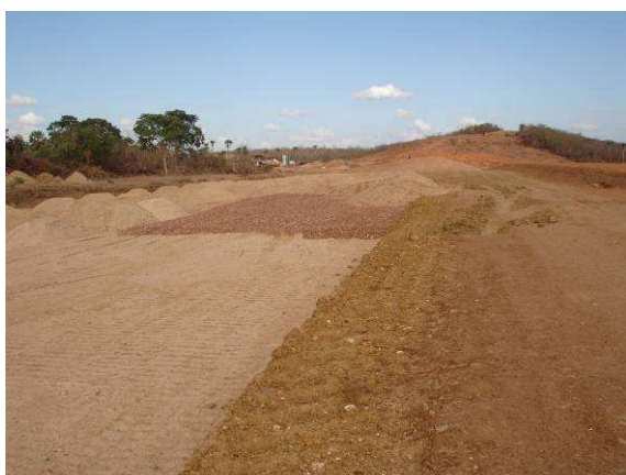
FOTO 27 – EXECUÇÃO DO TAPETE DRENANTE.
