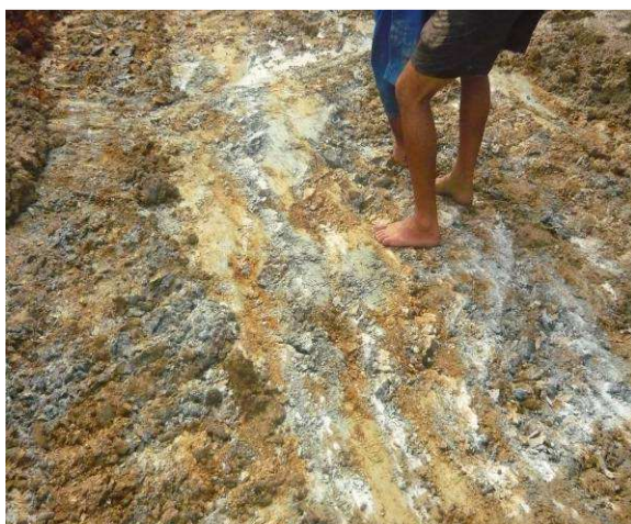
FOTO 77 – TOPO ROCHOSO NA FUNDAÇÃO DO MACIÇO PRINCIPAL
