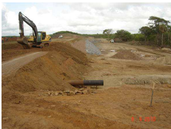
FOTO 35 – REGULARIZAÇÃO DO TALUDE DE JUSANTE
