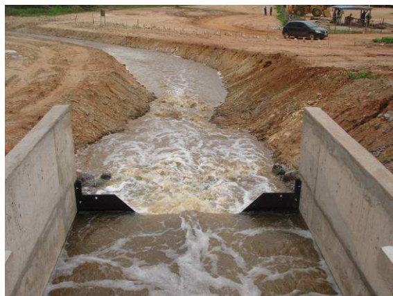
FOTO 106 – VISTA DE JUSANTE PARA MONTANTE DO VERTEDOURO TRIANGULAR E CANAL DE DESCARGA
