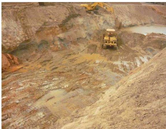
FOTO 75 – MACIÇO PRINCIPAL - ESCAVAÇÃO DA FUNDAÇÃO ENTRE A EST. 50 E 52
