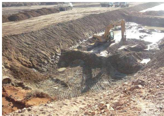
FOTO 14 – BARRAGEM PRINCIPAL - ESCAVAÇÃO DO CUT-OFF NA PRESENÇA D'ÁGUA
