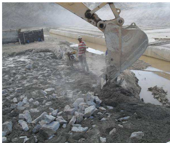
FOTO 116 - SANGRADOIRO - CONCRETAGEM DA BASE DO PERFIL CREAGER
