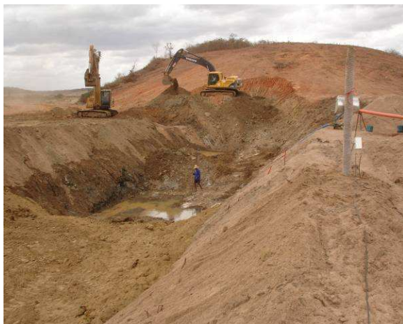
FOTO 79 – ESCAVAÇÃO DA FUNDAÇÃO NA OMBREIRA ESQUERDA DO MACIÇO PRINCIPAL
