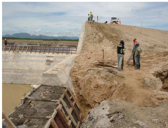
FOTO 152 - SANGRADOIRO – MURO DO LADO ESQUERDO, ATERRO DA BARRAGEM AUXILIAR 2 E CONCRETAGEM DO MURO 5.
