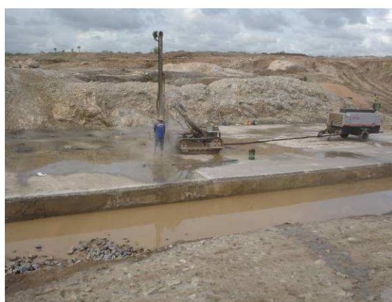
FOTO 114 - EXECUÇÃO DOS FUROS PARA COLOCAÇÃO DE TIRANTES.
