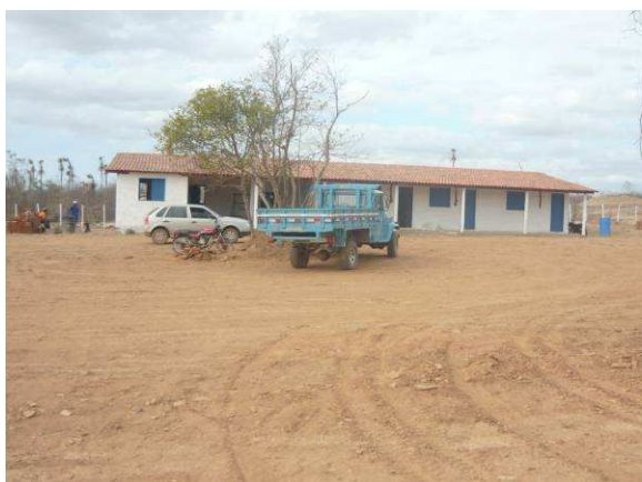
FOTO 3 – CANTEIRO DA OBRA.
