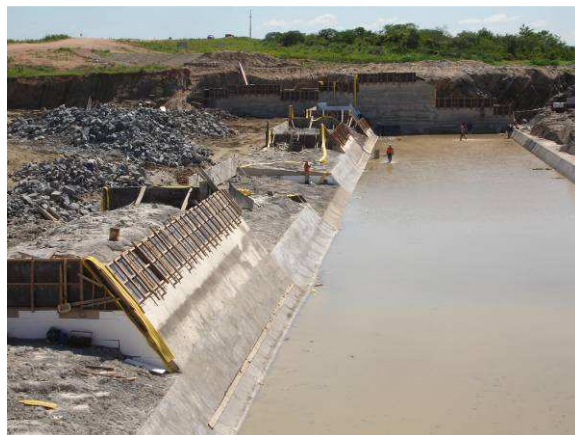
FOTO 146 - SANGRA DOURO - VISTA DOS MÓDULOS 1 AO 7 DO PERFIL CREAGER. AO FUNDO MURO ESQUERDO.
