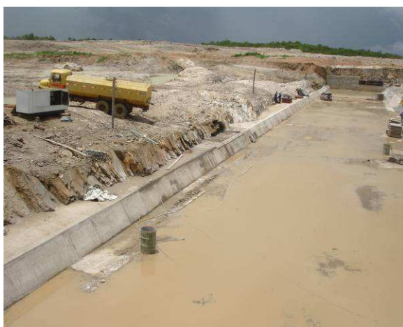
FOTO 143 - SANGRA DOURO - BACIA DE DISSIPAÇÃO E MURO FRONTAL. OBSERVAR PREENCHIMENTO DE CONCRETO ENTRE O MURO E ROCHA.
