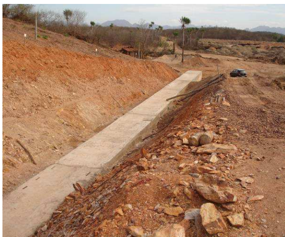
FOTO 89 – CONCRETO DE REGULARIZAÇÃO DA TOMADA D'ÁGUA.
